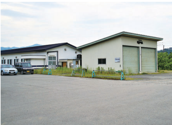
解体を待つ機械保管庫
