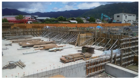
2mほどの段差がある
